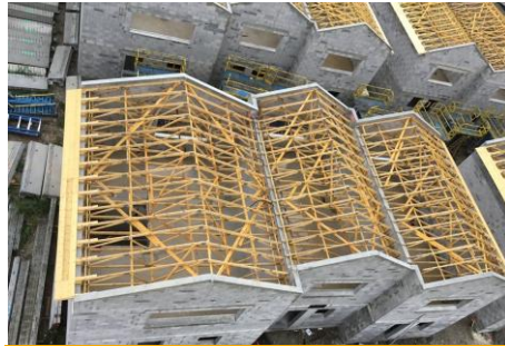
CHARPENTE BOIS INDUS
