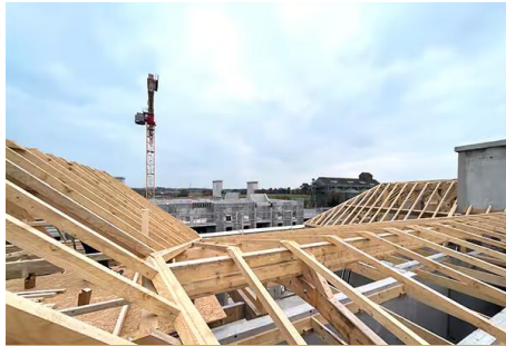
CHARPENTE BOIS TRADI
