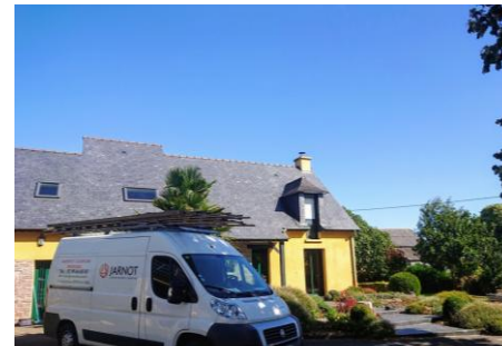
TRAVAUX SERVICES TOITURE
